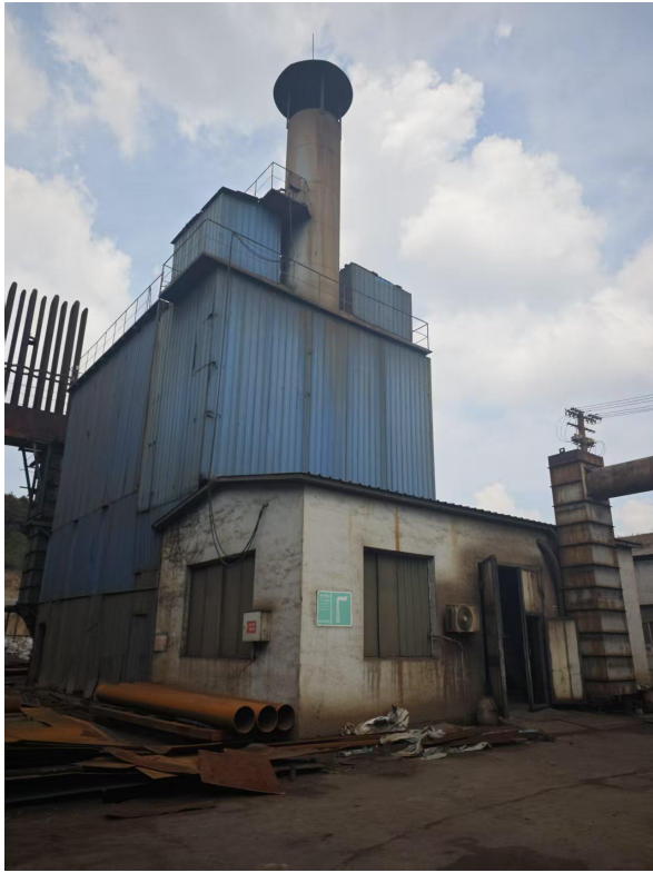
图 5-6 排气筒及在线监测室
