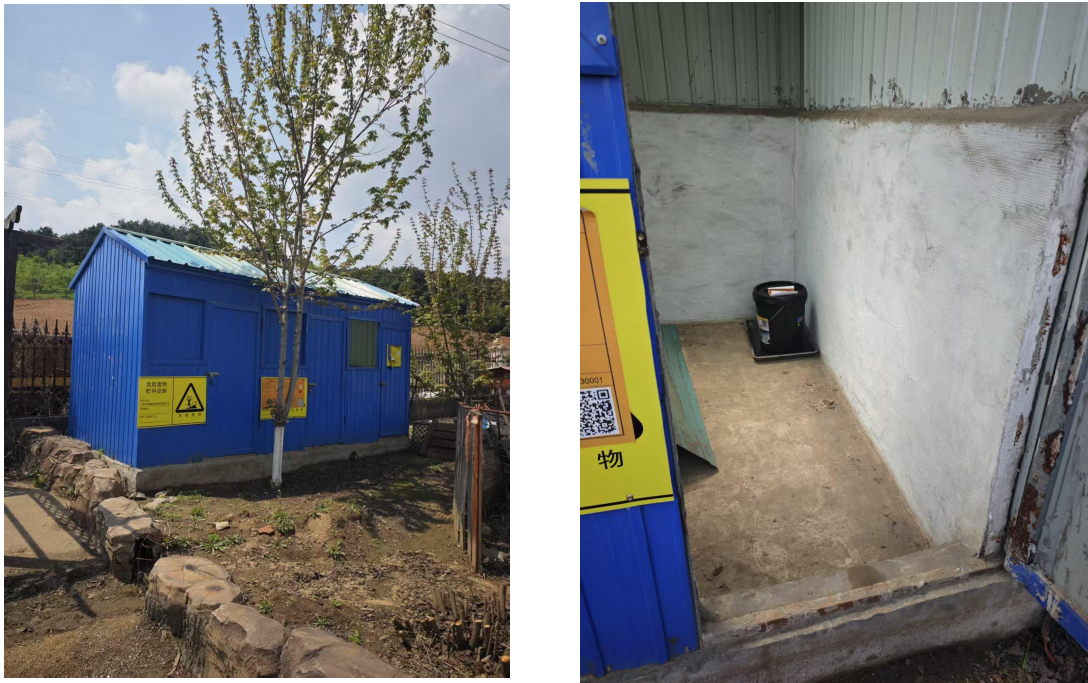
图 5-8 危废贮存设施
