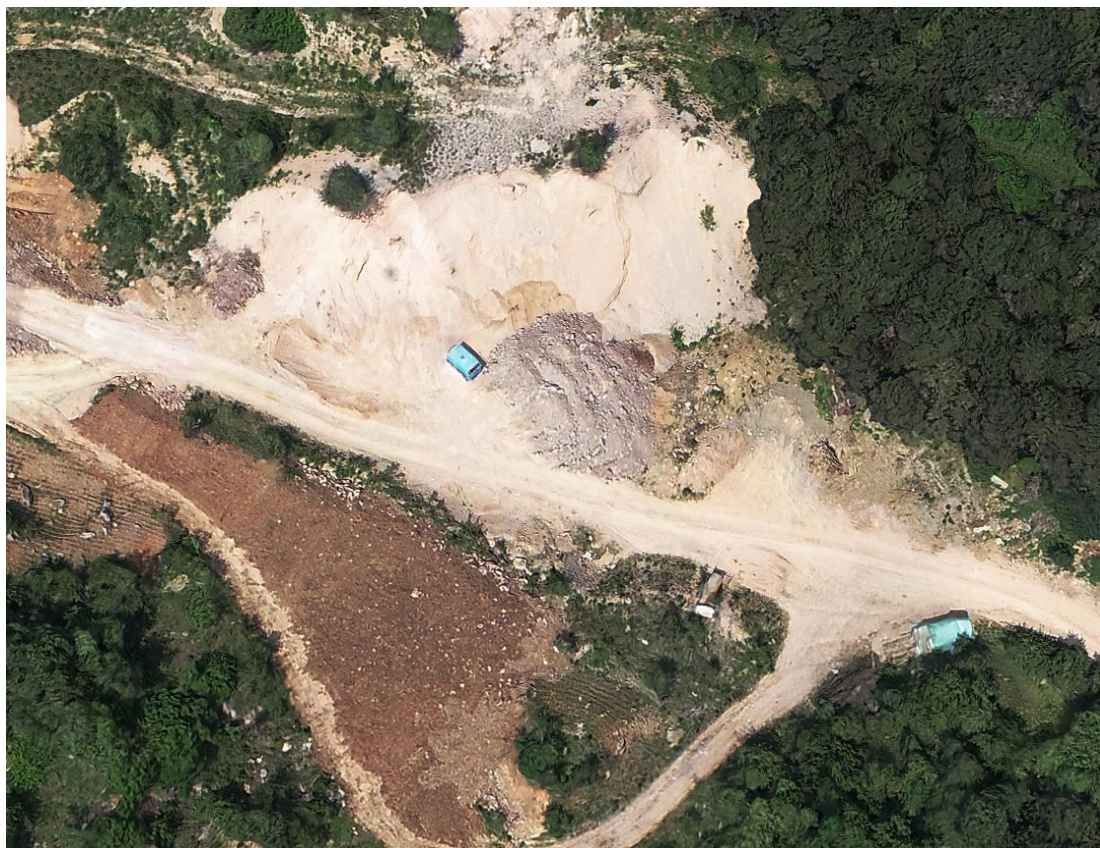
照片 3-3 原破碎场和堆料场
