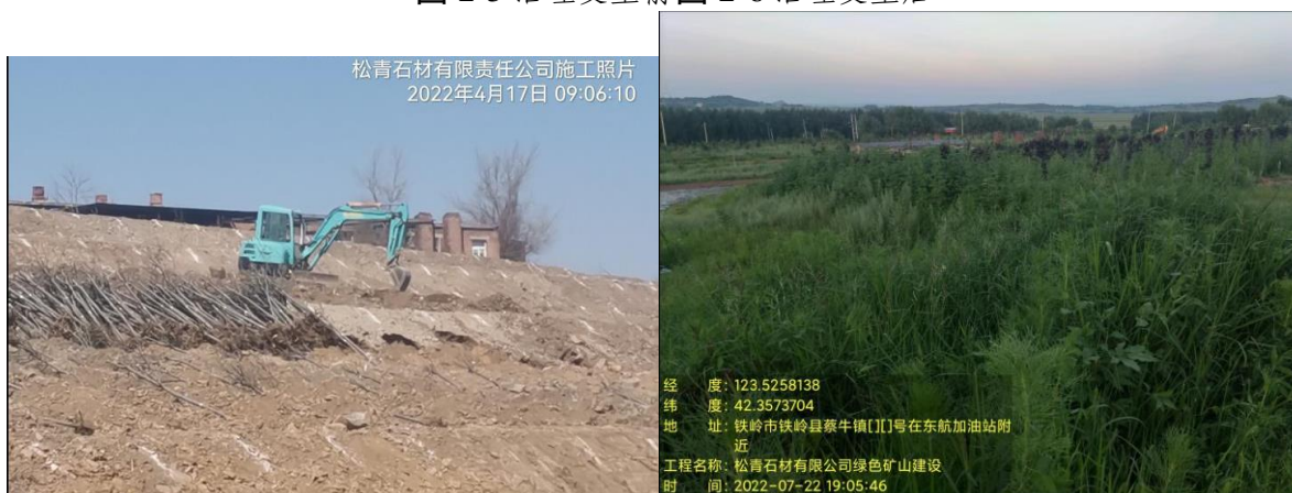
图 2-7 治理复垦前) 图 2-8 治理复垦后)
