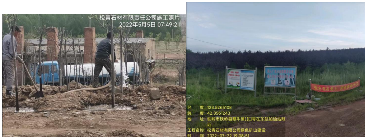
图 2-5 治理复垦前图 2-6 治理复垦后
