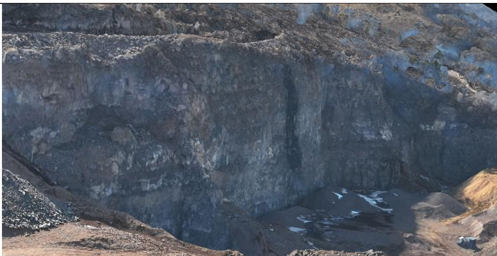
图 3-1 矿山部分边坡照片
