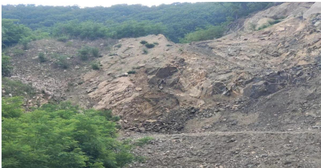
照片3-1 现状采坑
