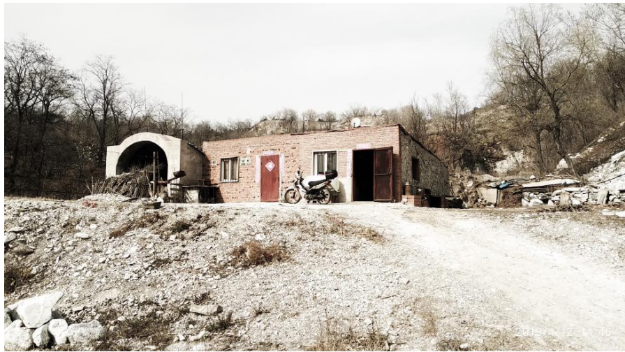
图 3-5 办公生活二区压占损毁土地现状
