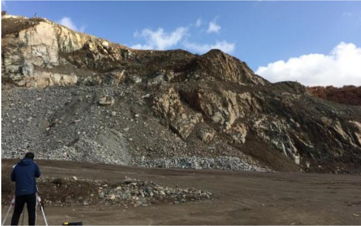
图 3-1 矿山部分边坡照片
