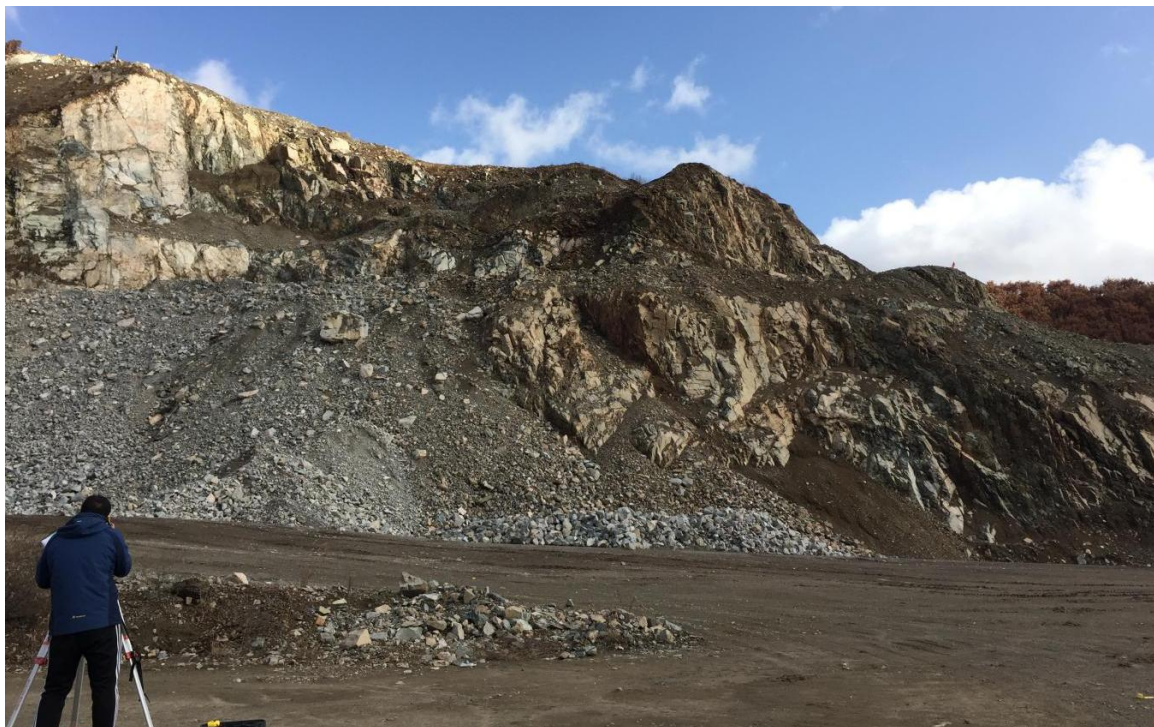
图 3-1 矿山部分边坡照片
